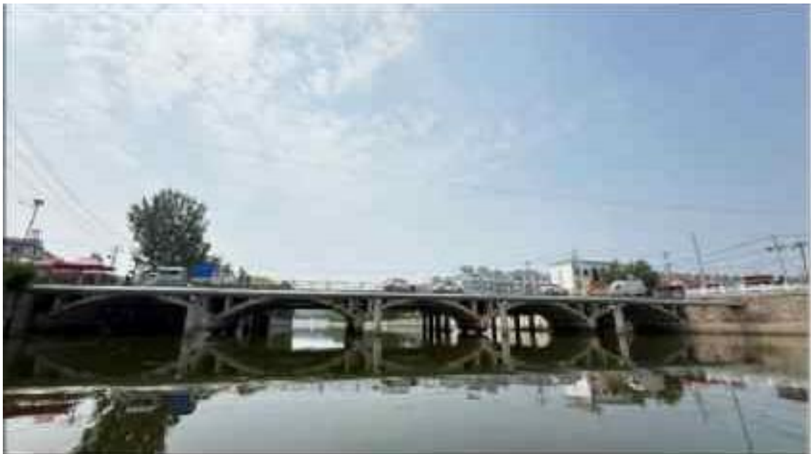
友谊街漳河桥现状
