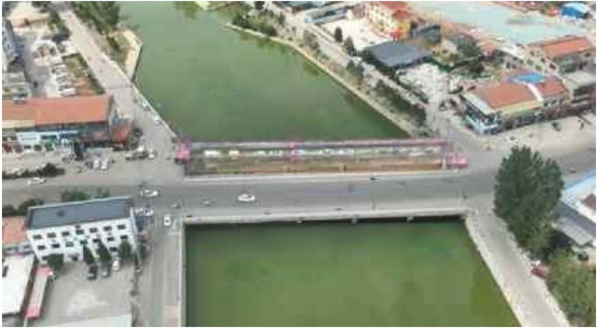
友谊街漳河桥现状
